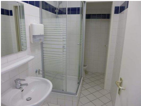
Sanitärbereich 1 m. Dusche.JPG
