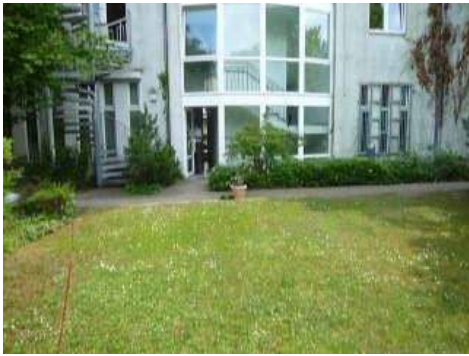
Hauseingang von der Hofseite.JPG
