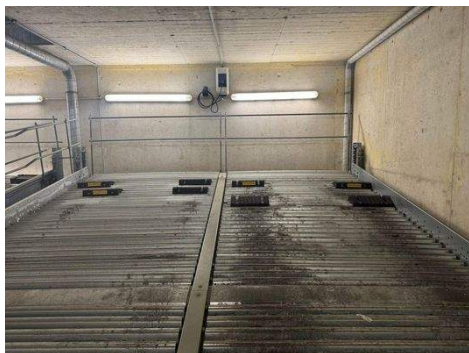
Ladestation für E- Fahrzeuge .jpg
